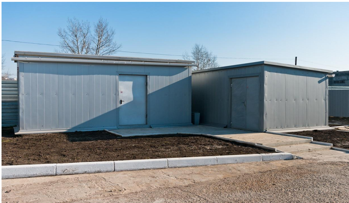
Фиг.57. Общ изглед на модулна пречиствателна станция за отпадъчни води от завод с персонал 350 работника.
