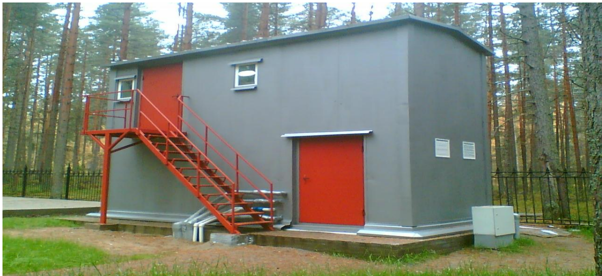
Фиг.52.Общ изглед на ПСОВ на база на използваните модули на фирма Екотон
