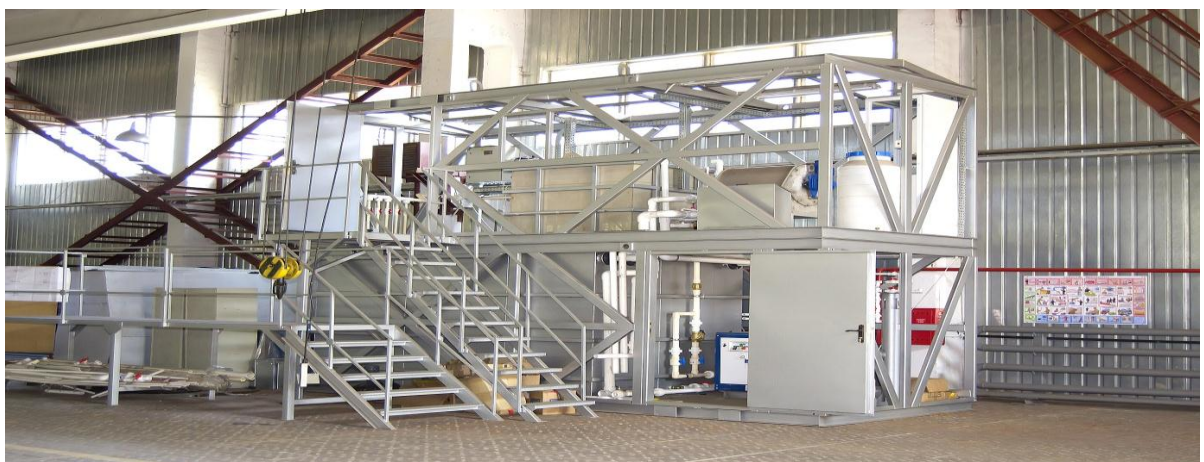
Фиг.53. Общ изглед на съоръженията във вътрешността на модула, преди цялостното оформление на външната сграда
