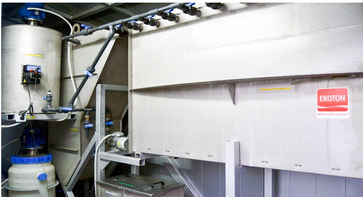
Фиг.55. Възела за физикохимично и биологично пречистване на отпадъчни води, във вътрешността на модулната ПСОВ
